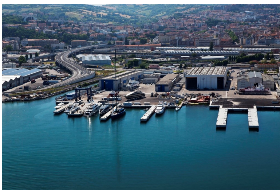
Figura 4-5 -Vista del cantiere Palumbo nel porto di Ancona
