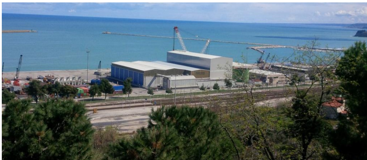
Figura 4-2 - lo stabilimento Walter Tosto nel porto di Ortona
