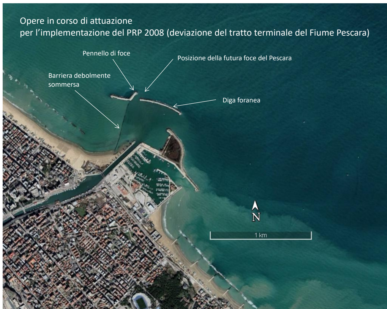
Figura 3-15 Porto di Pescara: stato attuale. Nella figura sono evidenziati i lavori di prima fase (Fase I) eseguiti dal Provveditorato alle OO.PP. Lazio, Abruzzo e Sardegna per l'attuazione del PRP 2008 che prevede la deviazione del tratto terminale del Fiume Pescara.
